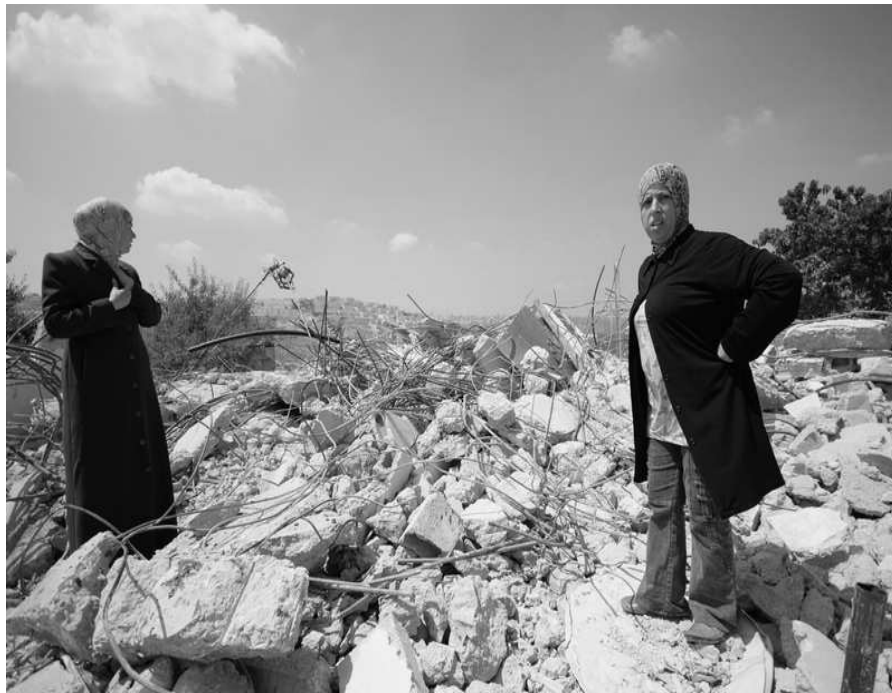
Foto: Palästinenser vor ihrem durch Bulldozer zerstörten Haus (Quelle: ICAHD)
